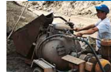
Malaxage et pompage de Mapecem avec une installation automatique
