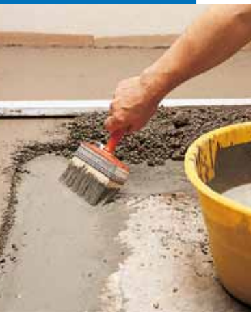
Application de la barbotine d'accrochage pour chape adhérente Mapecem
