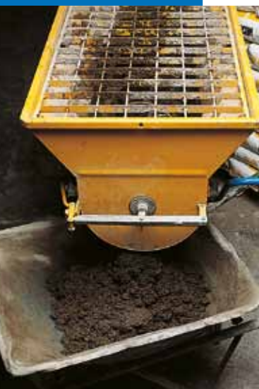
Malaxage de Mapecem avec un malaxeur horizontal
