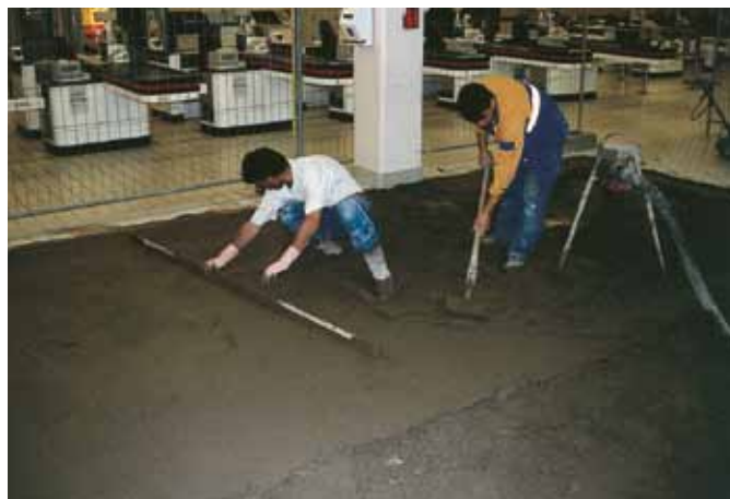
Réparation rapide d'une chape dans un supermarché
