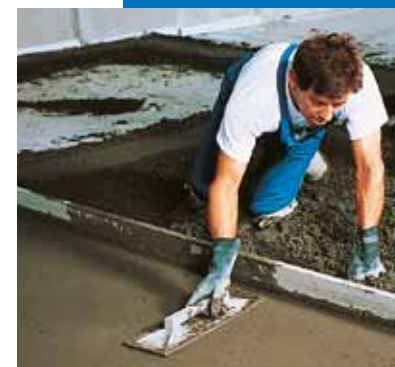
Finition par talochage du mélange Mapecem
