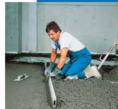
Étalement etamage du mélange Mapecem
